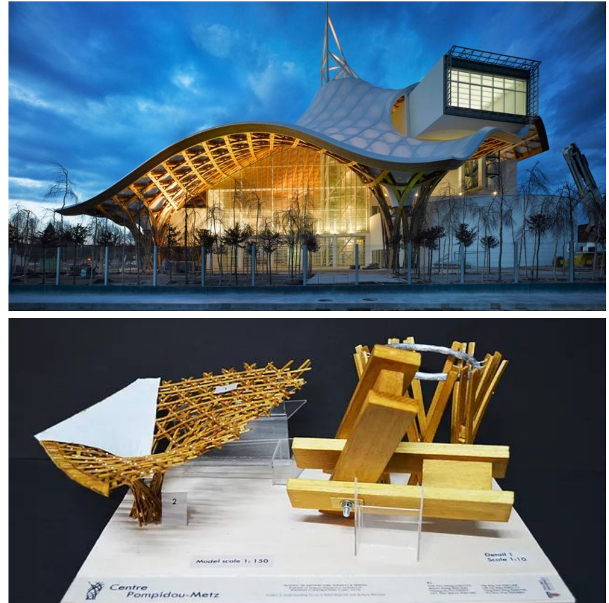
Kultuurikeskuse Metz punutis-katusekonstruktsiooni makett ja sõlm. Centre Pompidou Metz, arhitekt Shigeru Ban. Keskuse ruutmeetreid kokku 10700m 2 . Hoone valmis 2010.
